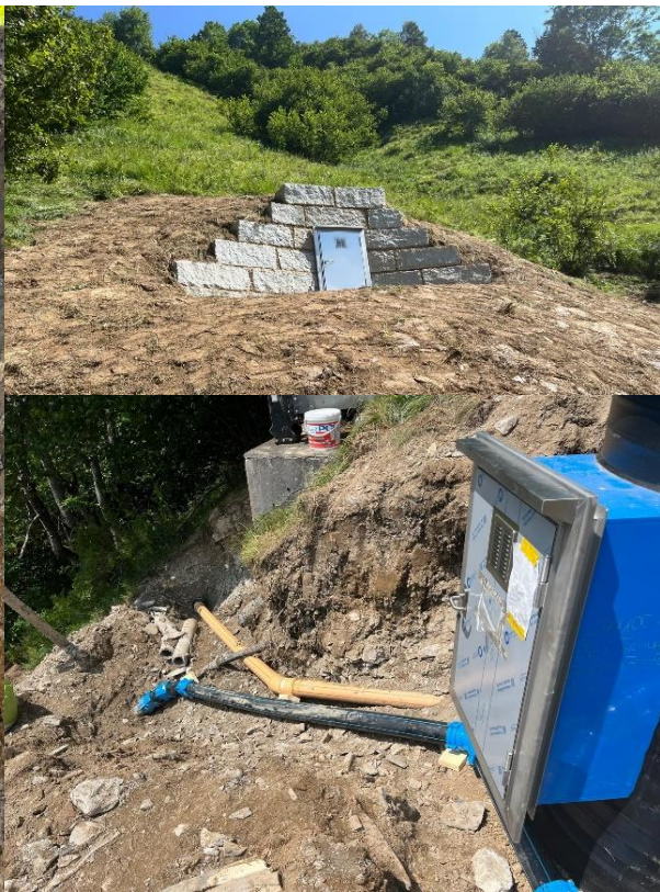
Druckbrecherschacht Tschuggen
